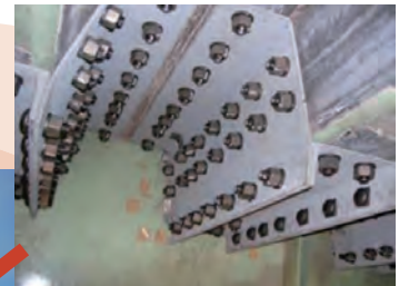
超高力ボルト:ボルト数の削減 ユビキタス型耐候性鋼:薄板化による軽量化
