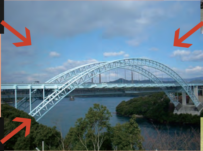
超高力ボルト:ボルト数の削減 ユビキタス型耐候性鋼:薄板化による軽量化
